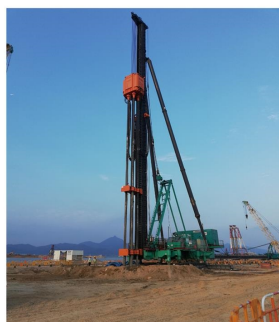
陆上工程 Land engineering
