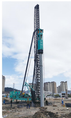
陆上工程 Land engineering
