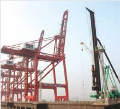
北仑宁波港码头项目 BEILUN NINGBO PORT PROJECT
