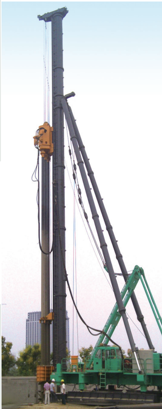
江西南昌大厦工地 Nanchang plaza, Jiangxi province
