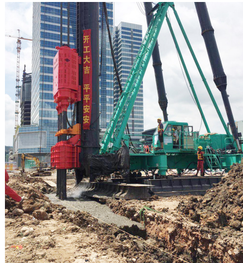
珠海工地 Zhuhai, Guangdong Province
