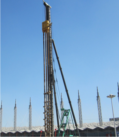
上海世博园工地 Shanghai Expo Garden
