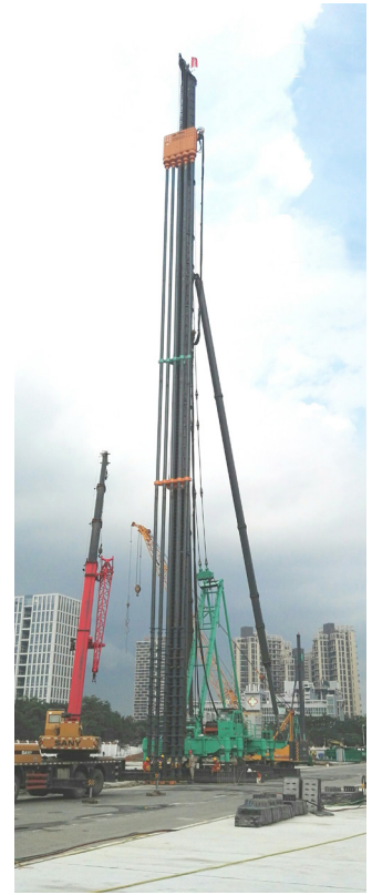
广州地铁工地 Guangzhou Metro
