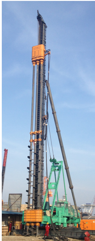
马来西亚工地 Malaysia
