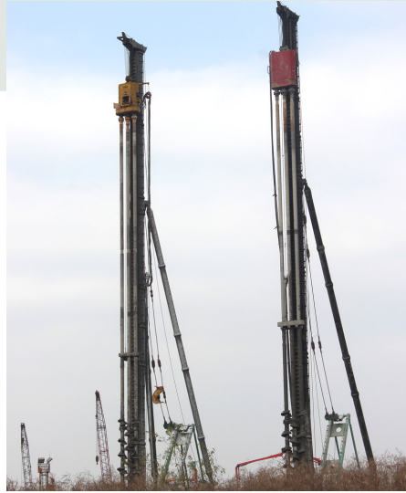
上海虹桥枢纽工地 Hongqiao CBD, Shanghai
