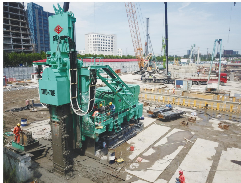
TRD-E工法机施工图
