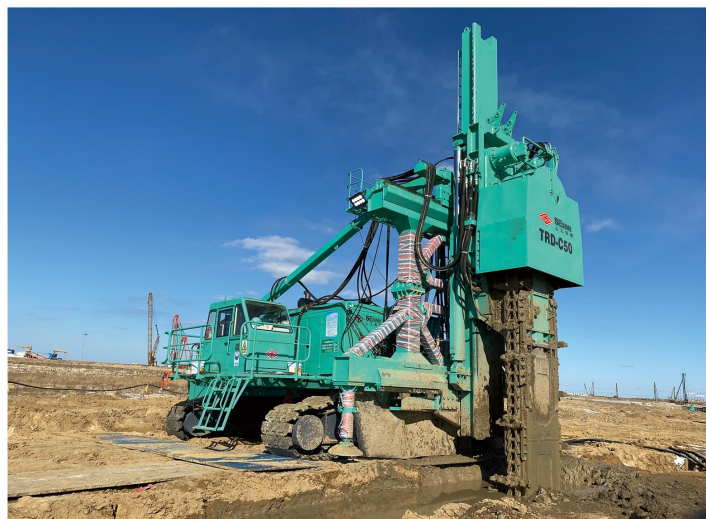
TRD-C50工法机华北项目现场施工
