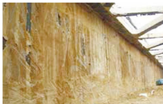
TRD工法施工开挖后的成墙效果
