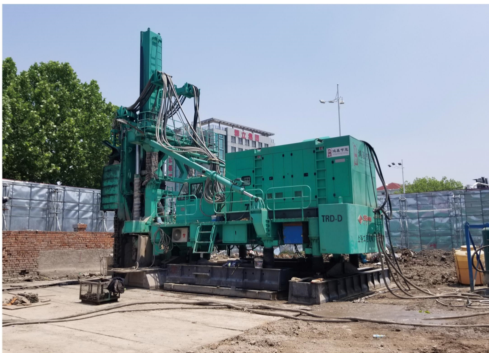
TRD工法机现场施工图
